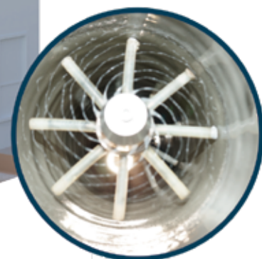
Tercer paso: REHABILITACIÓN
