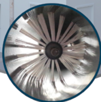
Segundo paso: LIMPIEZA
