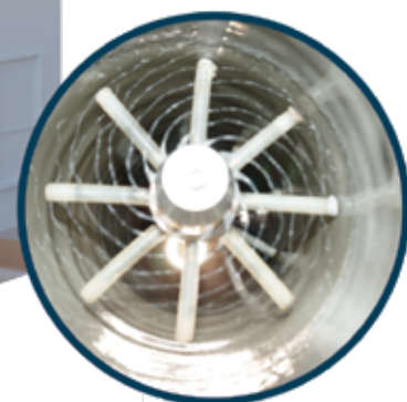
Tercer paso: REHABILITACIÓN
