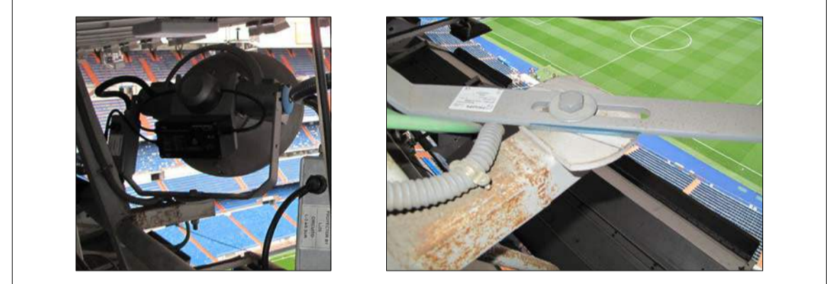
DETALLE DE ANCLAJE DE PROYECTORES A PASARELA
